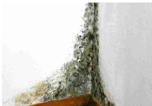
Фото 2 Образование плесени углах помещения.
